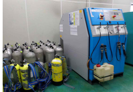
(d) HP compressor and bailout tanks
