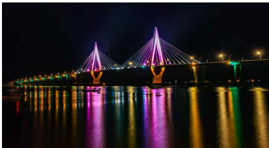
(d) Wonsananmyeon Bridge
